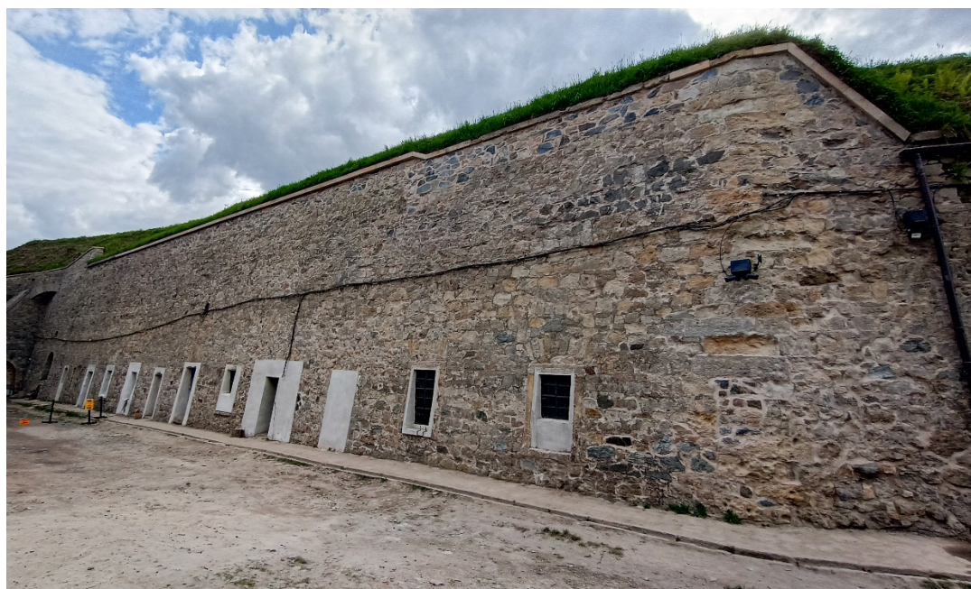
Zdjęcie: Wyremontowana ściana Wysokiego Redanu
