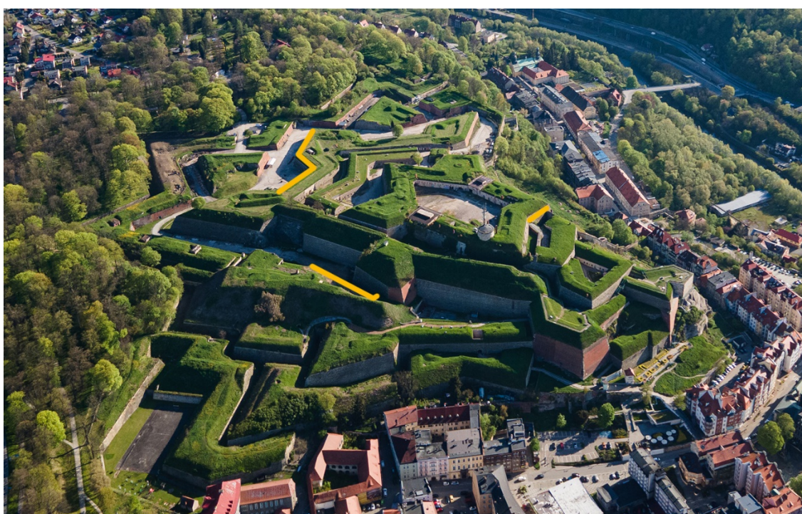
Zdjęcie: Kolorem żółtym zaznaczono ściany wymagające pilnej interwencji
