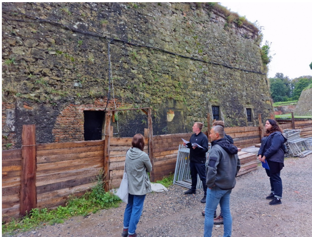
Zdjęcie: Oględziny Wysokiego Redanu (Dolnośląski Wojewódzki Konserwator Zabytku, nadzór inwestora, wykonawca)
