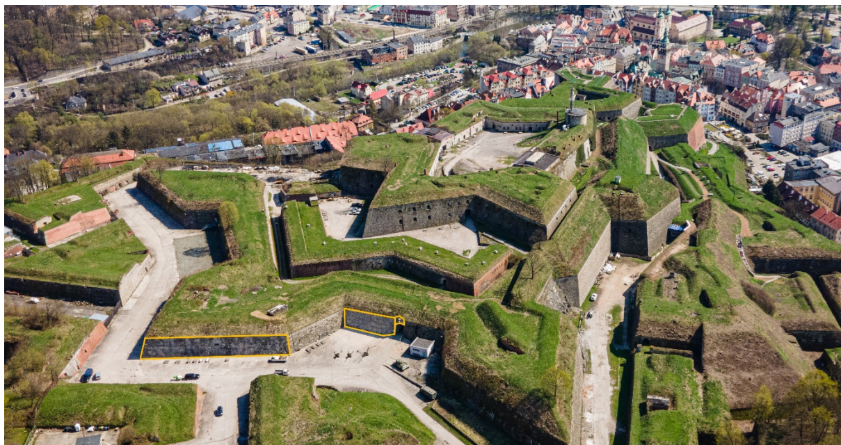
Zdjęcie: Wyremontowane ściany: kurtyna Ludmiła-Wacław (I etap), czło bastionu Ludmiła
