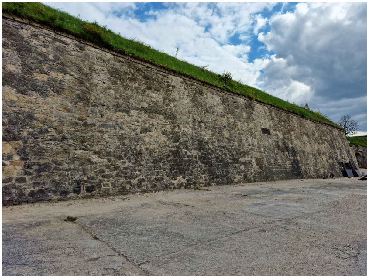
Zdjęcie: Wyremontowane czoło bastionu Ludmiła
